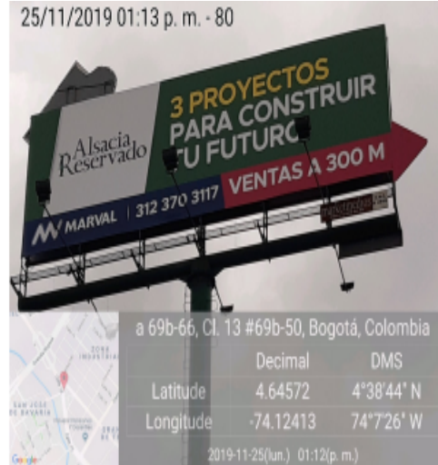
Foto 2. Vista del Panel y de estructura de la valla ubicada en la Diagonal 13 No. 69B-58 (Dirección catastral actual), orientación Oeste-Este.
